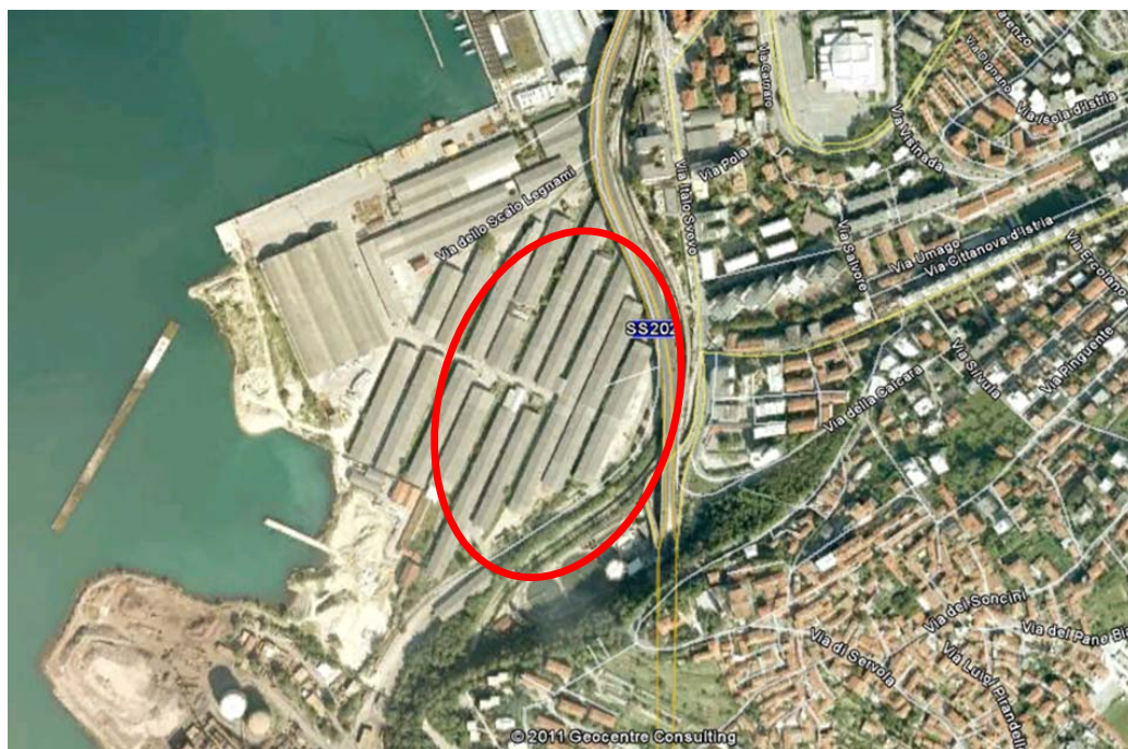
Figura 1: Foto dell'area dell'intervento dall'alto
