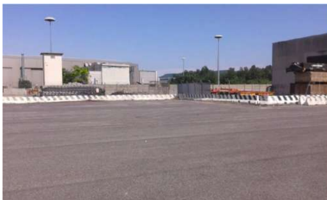
Foto 3.2 - Parte del piazzale asfaltato destinato alla sede operativa.
