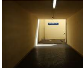
Presenza sottopassaggio tra le banchine
