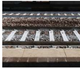
Mancato adeguamento banchine
