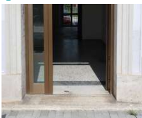
Accessibilità edificio stazione-banchina 1
