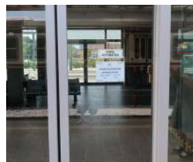
Accessibilità edificio stazione-banchina
