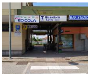
Banchine non coperte
