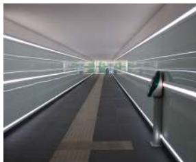
Accessibilità sottopassaggio tra le banchine
