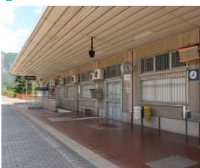
Accessibilità edificio stazione-banchina n.1
