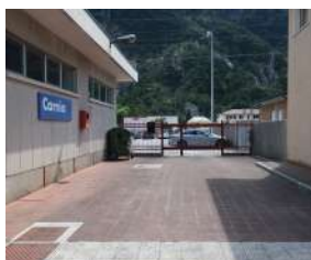
Potenziale accessibilità strada-banchina n.1
