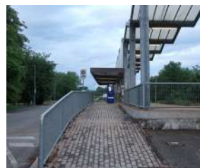
Accessibilità strada-edificio stazione
