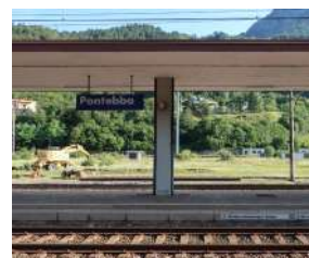
Mancato adeguamento banchine
