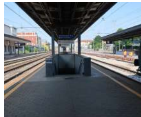
Mancanza segnaletica direzionale per raggiungere interscambio
