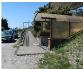
Accessibilità strada-banchina n.2
