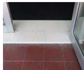
Accessibilità strada-edificio stazione-banchina n.1
