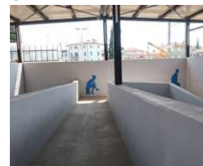
Accessibilità tra tutte le banchine tramite rampa
