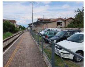
Mancanza adeguamento banchine
