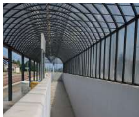
Accessibilità tra tutte le banchine tramite rampa
