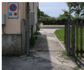
Accessibilità strada-banchina n.1
