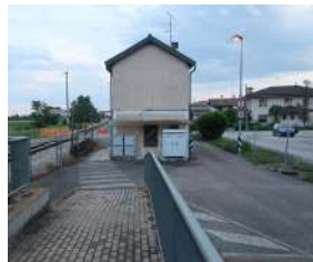
Accessibilità strada-edificio stazione
