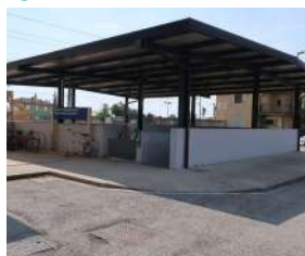
Accessibilità tra tutte le banchine tramite rampa
