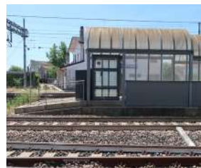
Parziale adeguamento banchine
