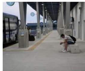
Presenza banchina coperta
