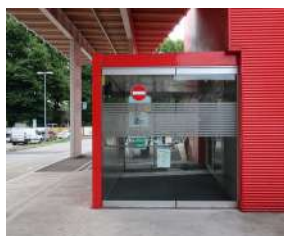
Accessibilità strada-edificio stazione
