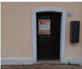
Mancata accessibilità strada-edificio
