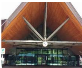
Accessibilità edificio stazione-banchina n.1
