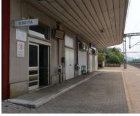
Assenza adeguata accessibilità edificio stazione-banchina 1
