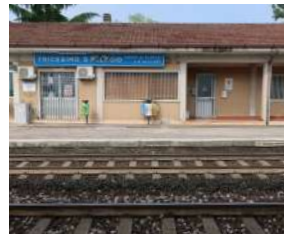
Mancanza adeguamento banchine
