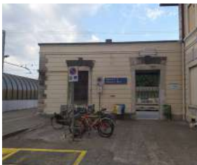
Presenza stalli biciclette in prossimità dell'edificio stazione
