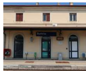
Mancato adeguamento banchine
