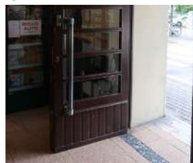
Accessibilità edificio stazione-banchina
