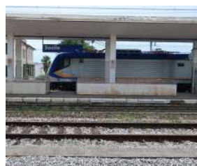
Mancato adeguamento banchine
