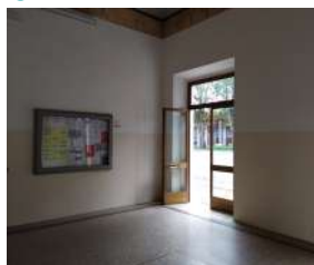
Accessibilità strada-edificio stazione
