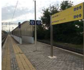
Accessibilità al binario 2 e 3 tramite rampa
