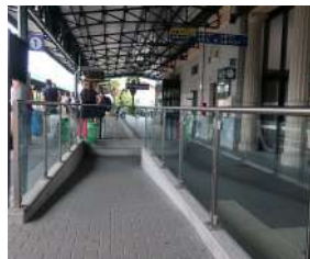
Accessibilità edificio stazione-banchina
