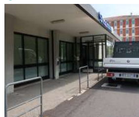
Accessibilità strada-edificio stazione
