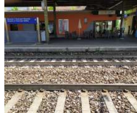
Mancato adeguamento banchine
