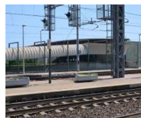
Mancato adeguamento banchine
