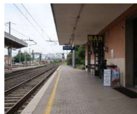
Assenza adeguamento banchine
