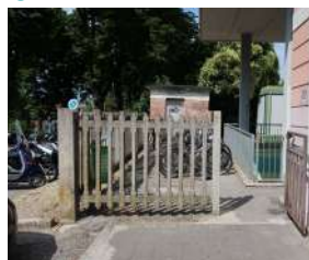
Accessibilità strada-banchina n.1
