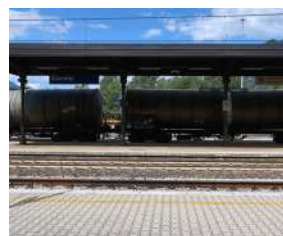
Assenza adeguamento banchine
