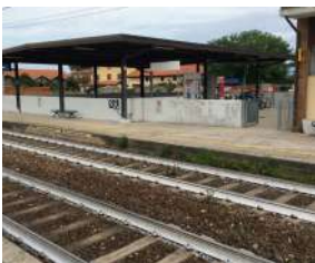
Accessibilità strada -banchina 1
