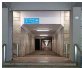
Assenza edicola, tabacchi e v.b. all'interno dell'edificio stazione
