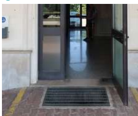
Accessibilità edificio stazione-banchina 1
