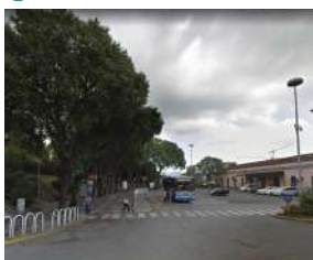
Assenza segnaletica direzionale per raggiungere interscambio
