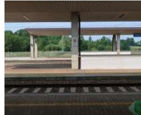
Mancato adeguamento banchine
