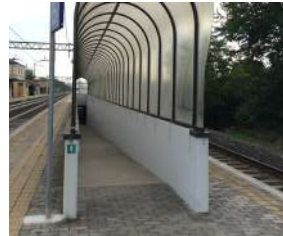
Rampa di accesso al binario 2 e 3
