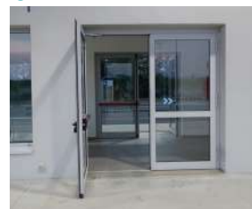
Accessibilità edificio stazione-banchina
