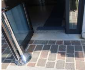
Accessibilità strada-edificio stazione
