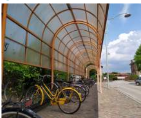
Presenza stalli biciclette coperti in prossimità dell'edificio della stazione
