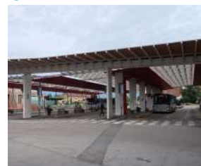
Accessibilità tra tutte le banchine
