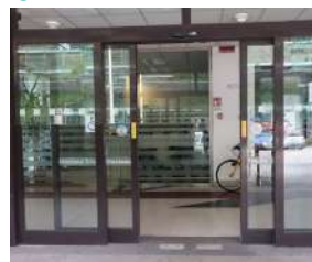
Accessibilità strada-edificio stazione
