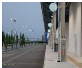
Accessibilità edificio stazione-banchina
